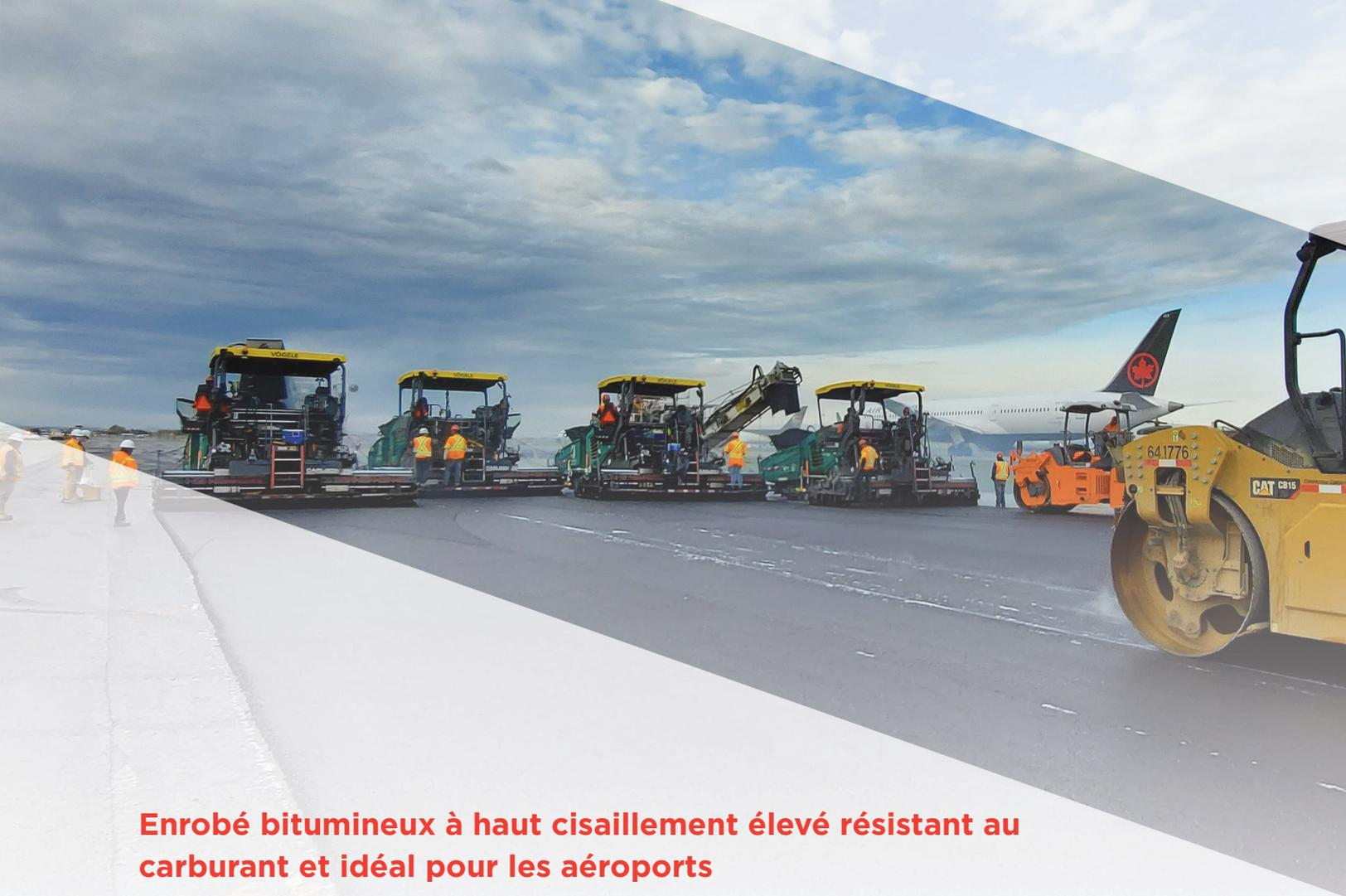
**Enrobé bitumineux à haut cisaillement élevé résistant au carburant et idéal pour les aéroports**
